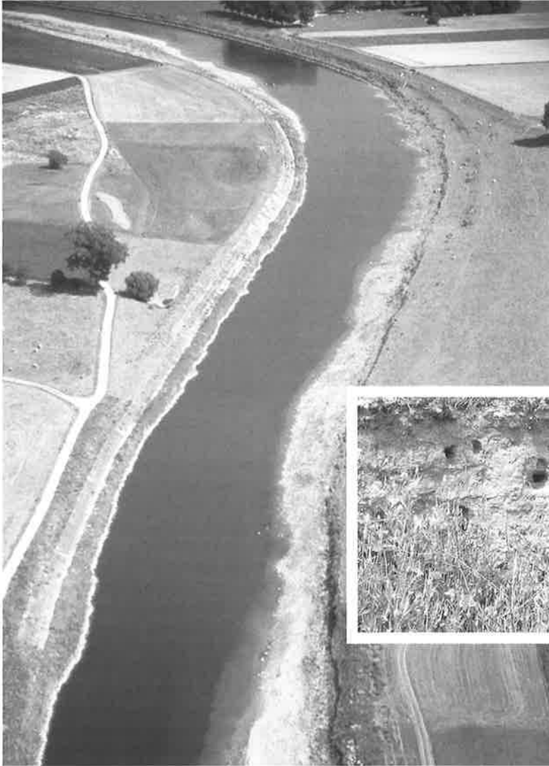
Grensmaas bij Koeweide, Grevenbicht, zomer 1996. Let op de betonnen oevers aan de Vlaamse zijde en de vrij afkalvende oevers aan de Nederlandse zijde. (foto's: F. Schepers)
