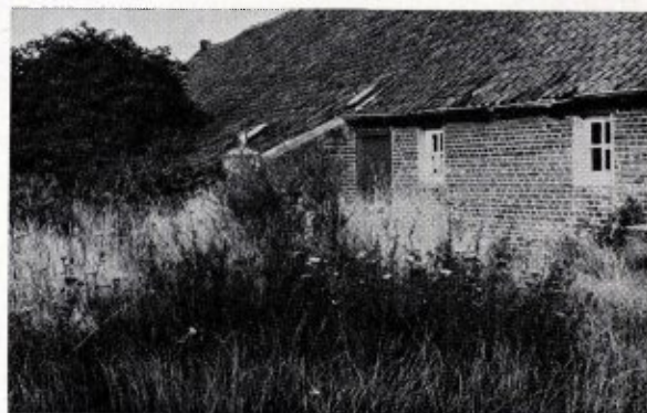
Oudste thans nog bestaande, boerderij nabij de Kootspeel. Vermoedelijk ong. 1750. Dak later gerestaureerd. Rietbedekking is verwijderd, en dak van waterafvoer voorzien. Het dak loopt schuin af tot bijna aan de grond. Links de onafscheidelijke vlier.
