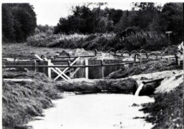
De stuw in de Lollebeek in aanbouw. Foto: M. van den Munckhof.
