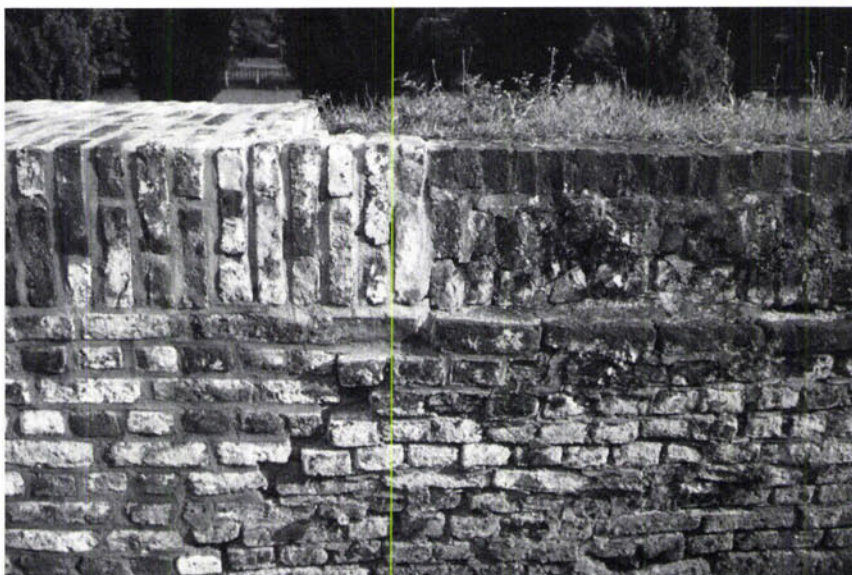
Figuur 13. Door het volledig glad dichtsmeren van de oude voegen met de keiharde Portland-cement is de kans op hervestiging van muurplanten vrijwel nihil geworden.
