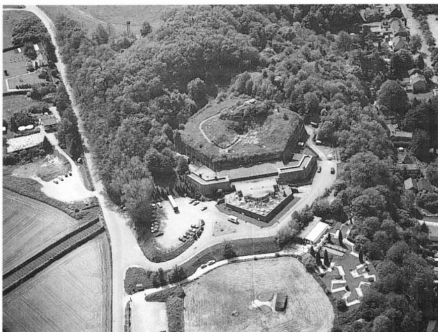
FIGUUR 5. Fort Sint-Pieter (situatie mei 1992). Door het kappen van het bos aan de rechter zijde van het fort wordt er een verbinding gecreëerd tussen het fort en de dagzomende kalksteenrotsen van de "Groote ingang" (foto: Fotografie Gemeente Maastricht. P.H.J. Quaedflieg en P.J.M. Rutten).
