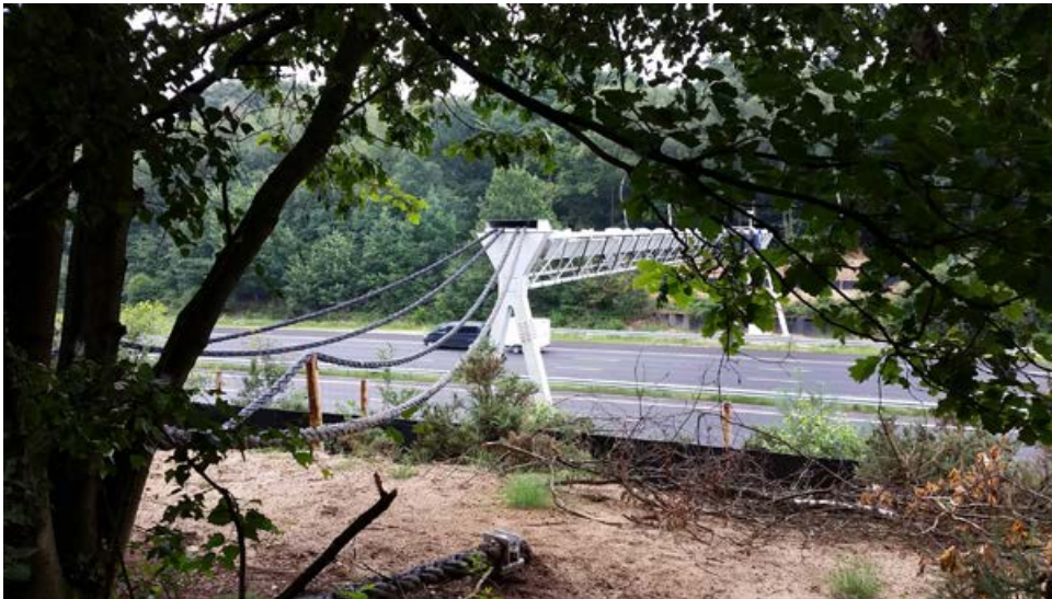
FIGUUR 7 Een aangepast verkeersportaal over de A12 bij Ede (Gelderland) voorzien van sloopstouwen dat door Eekhoorn ( Sciurus vulgaris ) en Boommarter ( Martes martes ) wordt gebruikt om veilig over te steken (foto: Johan de Bijl, Rijkswaterstaat).
