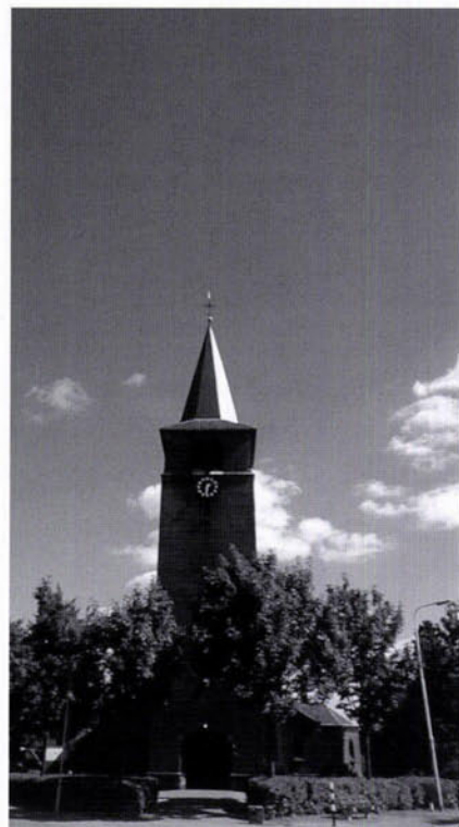
FOTO 1 Limburgse kerken: gastvrij voor vleermuizen! De kerkzolder in Castenray herbergt een kolonie Bruine grootoorvleermuizen en de grootste kolonie Laatvliegers in Limburg.
