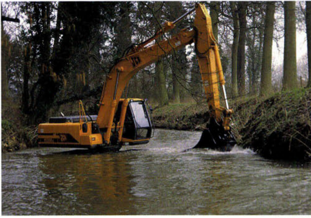
FOTO 4 EN 5 Het weghalen van oeverbeschoeiingen en laten liggen van omgevallen bomen stimuleren bij Ingendael (Valkenburg) meandering en spontane stroombedverbreding (foto: Bart Peters).
