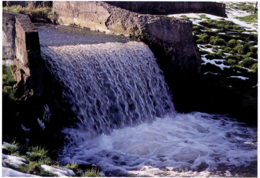
FIGUUR 4 Verdeelwerk in de Zieversbeek te Lemiers; een niet te passeren barrière voor kleine beekvissen (foto: R. Gubbels).
