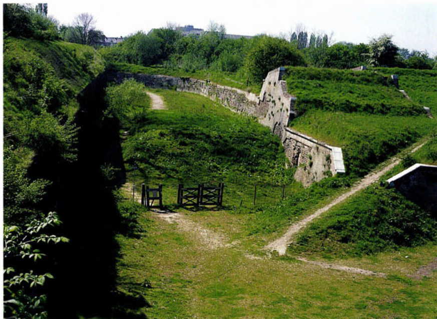
FIGUUR 1 Blik op een deel van de monitoringroute (foto: Hub. Reumkens).
