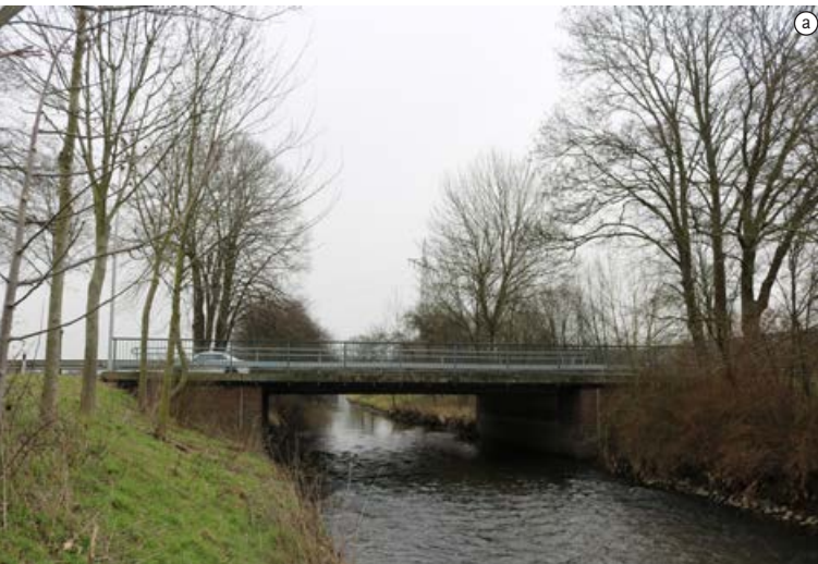
FIGUUR 14a De doorgang van de Worm onder de Hochbrückerstrasse bij Hochbrück (D). Dit is een groot knelpunt bij de migratie van Otters ( Lutra lutra ) (foto: Ton Lenders).
