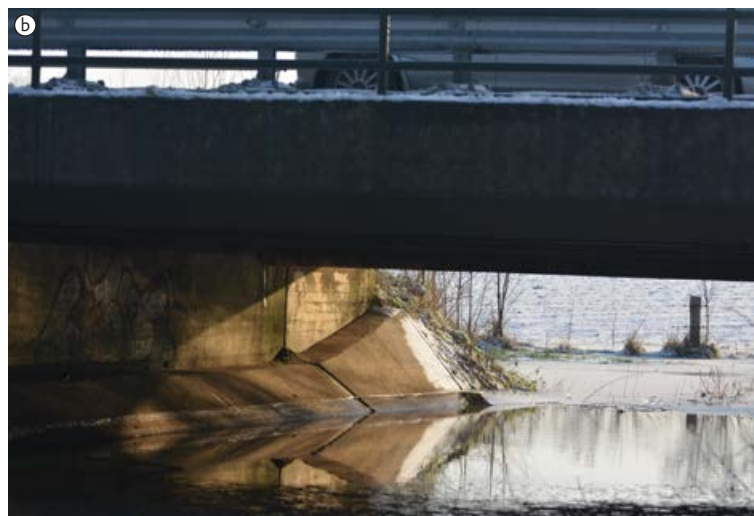
▼ FIGUUR 11 Een voormalig migratieknelpunt bij de brug over de Melicker Leigraaf en de Heinsbergerweg in Melick (a) dat inmiddels door het aanbrengen van een looprichel (b) is opgelost (foto's: Steven Jansen).
