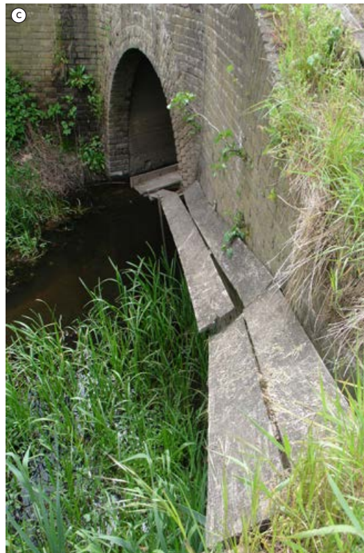
▲ FIGUUR 13a Migratieknelpunt bij Rothenbach. De Roode Beek loopt hier op de rijksgrens met een duiker onder de N570 door (foto: Steven Jansen).
