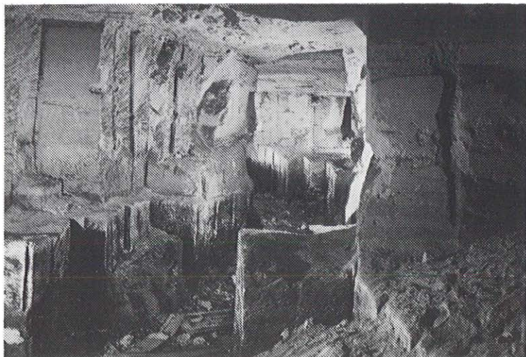
De rechter hoofdgang in het westelijke deel die uitgediept is om er in te kunnen afwateren. Foto 6
