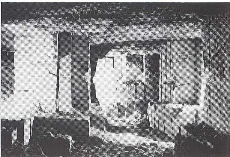
Uitdieping en roofofbouw in de rechter hoofdgang. Foto 33
