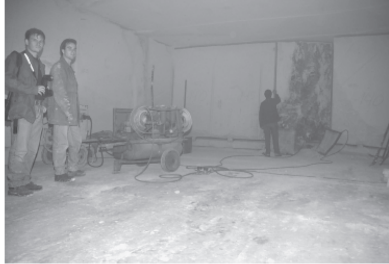
Foto 4. Losbreken van blok 3 met behulp van luchtdruk.
