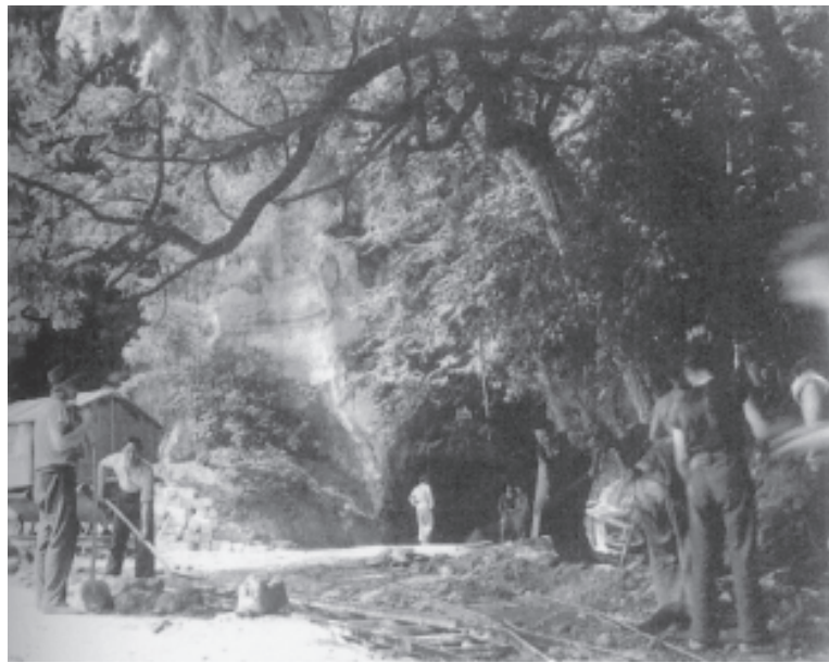
afb. 2: 10 juli 1944. Belgische arbeiders bezig met de aanleg van het spoor bij de ingang naar de Boschberg. 8
