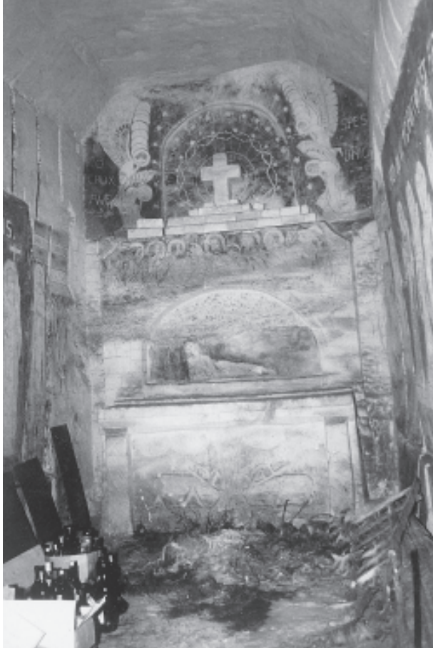
afb. 7: De kapel uit 1922-1924 in de Schark, nu gebruikt als stookplaats en rommelopslag
