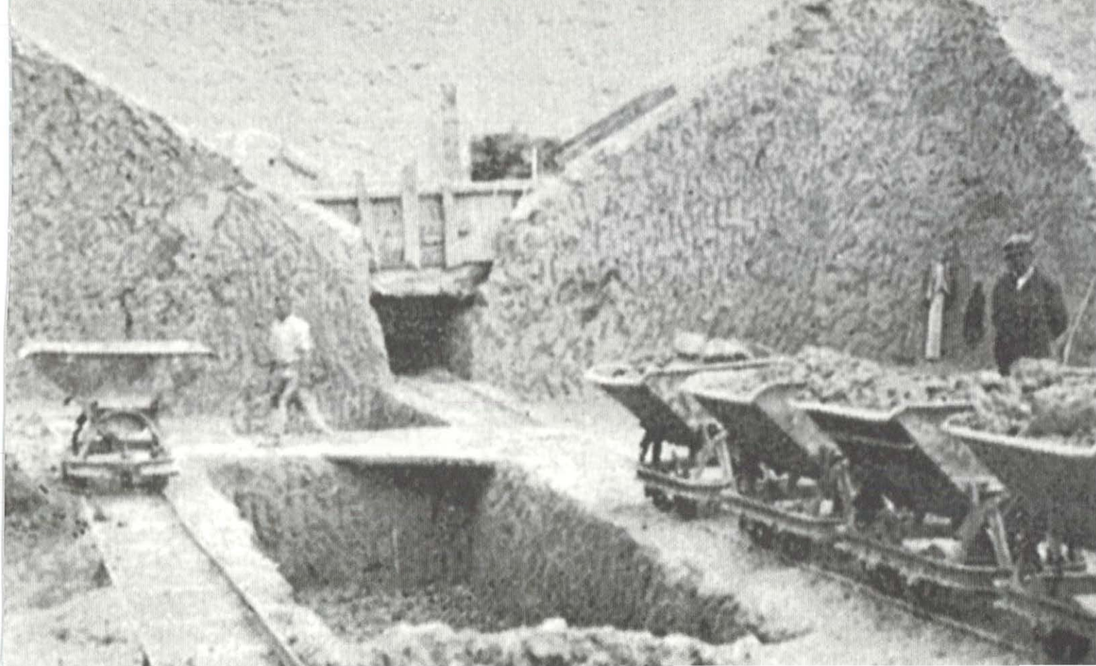
figuur 5: Open groeve te Vijlen van de VNPC.
