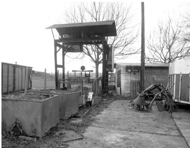
FIGUUR 4: Monte-charge boven schacht.
