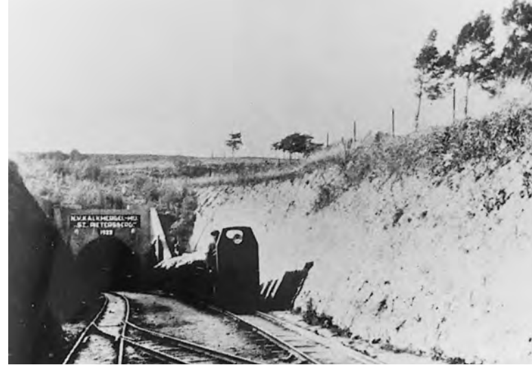
FIGUUR 3: Tunnelingang op de oostelijke helling van den St. Pietersberg en mergeltrein met Diesellocomotief
