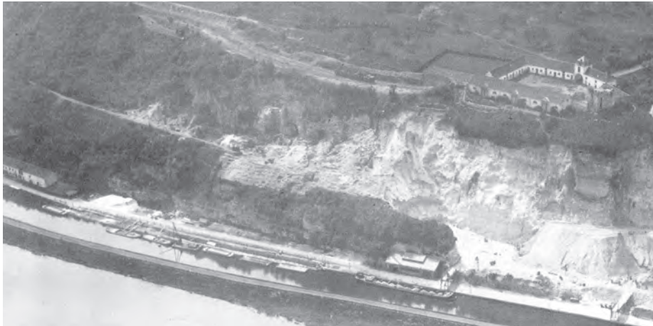
▲ AFBEELDING 11, boven: De afgraving nadert de ingangspartij, 1925/1926. (Uit: Van mergel tot cement 42 )
