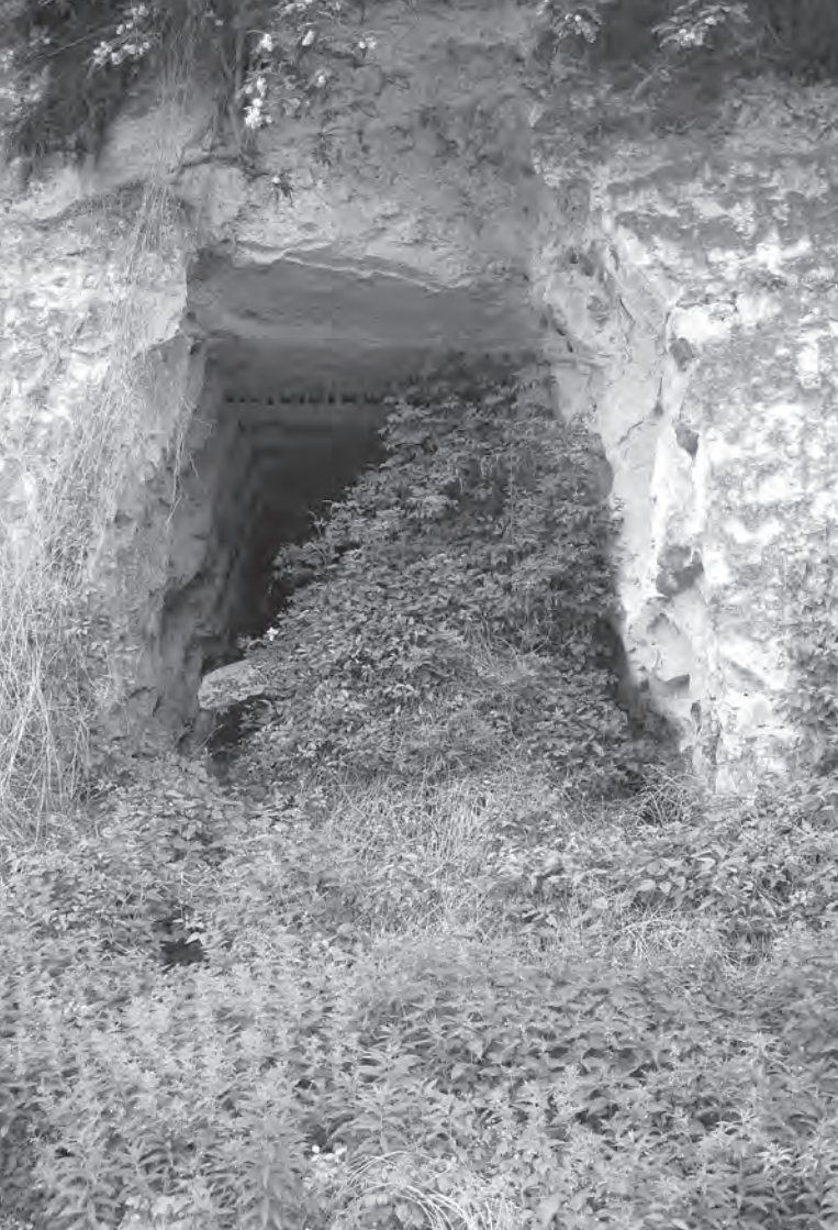
AFBEELDING 14: ingang linker tunnel
