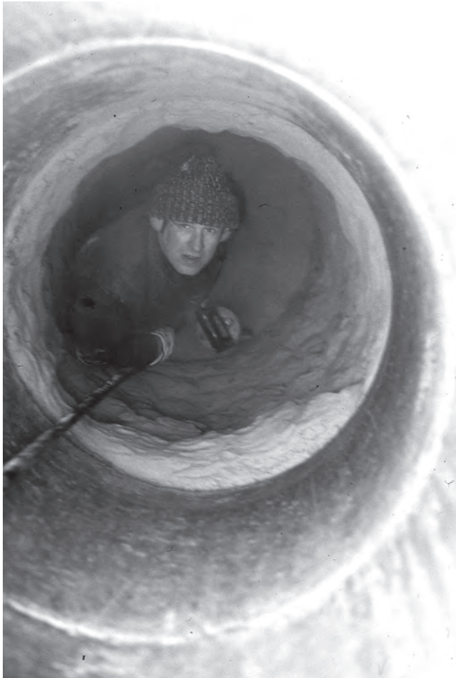
AFBEELDING 13: Het afdiepen van schachten in 1980 boven de Lacroixberg bij de opvullingen onder de Misweg (foto Ton Breuls)
