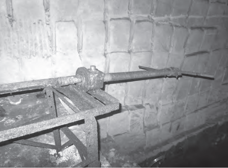
AFBEELDING 16: Horizontale boorinstallatie in het Avergat (foto Ton Breuls)
