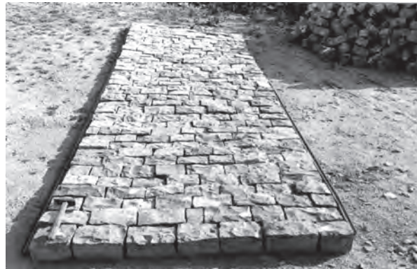
AFBEELDING 3a. en 3b: Gekapte vuursteen voor de maaltrommelbekleding in de keramische industrie (foto NHMM, 1969)
