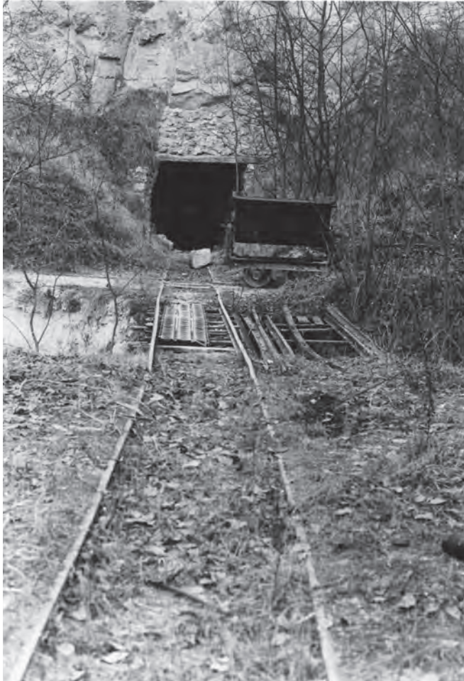
AFBEELDING 36: Ingang Pirpagnet 1 met de rails en een wagonnetje. Halverwege het draaipunt en de transportsleuf met het bruggetje (foto T. Breuls, 1977)
