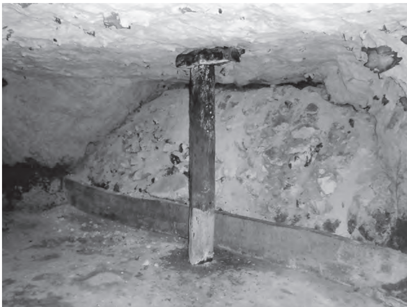
AFBEELDING 28: Steunpilaren van spoorbuisen (foto T. Breuls, 2014)
