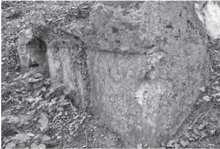
AFBEELDING 9: De wand met gereedschapssporen. Hier is duidelijk te zien dat deze ontginningsactiviteiten onderaards plaatsvonden. Er werd gebruik gemaakt van een bovenvoor, dat altijd op een onderaardse groeve duidt. Daarnaast ziet men boven de bovenvoor een overhang van de mergel, het restant van het plafond
