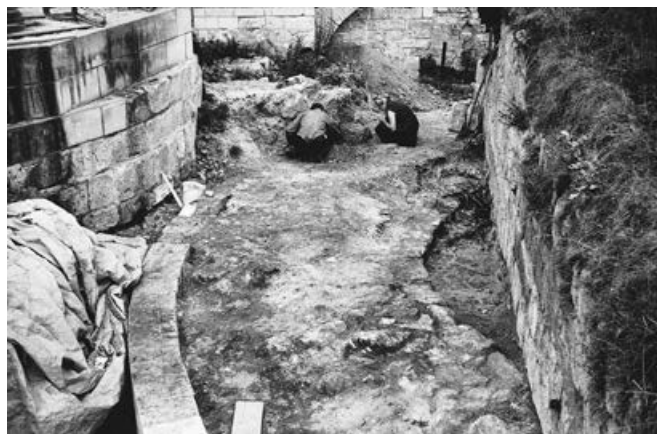
AFBEELDING 17: Fundament van de zestienhoekige toren die uit gekapte mergelblokken was opgetrokken (Collectie Jacquo Silvertant)
